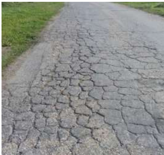
Degradări sub formă de gropi, faianțări, tasări, pe DJ 672E
