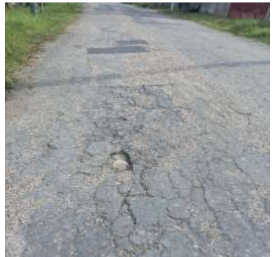
Degradări sub formă de gropi, faianțări, tasări, pe DJ 672E
