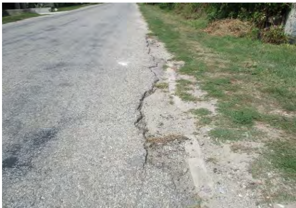
Degradări ale părții carosabile pe DJ 672C
